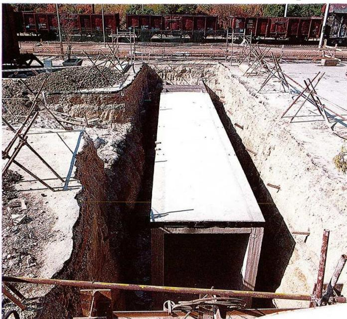
*Particolare del monolite fuori opera per il sottopassaggio della stazione ferroviaria di Alba Adriatica, realizzato per conto del Compartimento di Ancona delle FFSS.*
