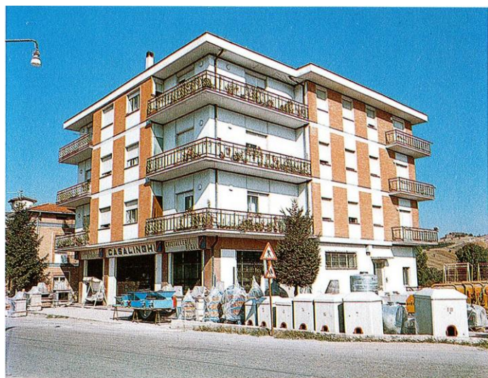
Edificio per civili: abitazioni e negozi dei fili Marroni in S. Onofrio
